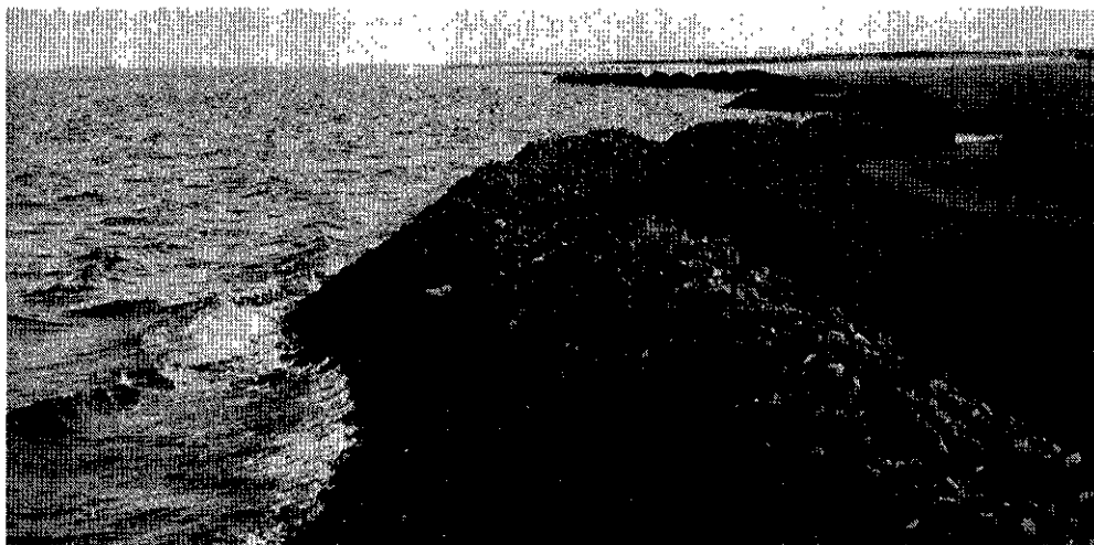
Afb. 10. Hompelvoet. Oeververdediging bestaande uit een grinddam op de oeverlijn
